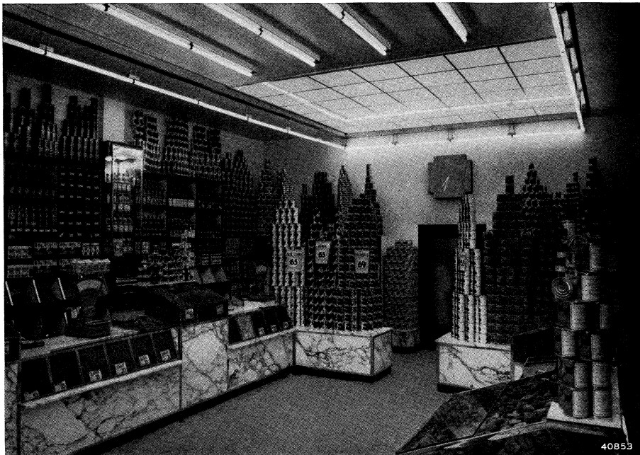
Een levensmiddelenbedrijf te Rotterdam, verlicht door 40 TL 100 buislampen.
