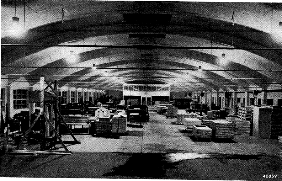
Een meubelfabriek te Nybro in Zweden, verlicht door 16 menglichtarmaturen, die met kwiklampen HO 1000 en 300 W gloeilampen zijn uitgerust.
