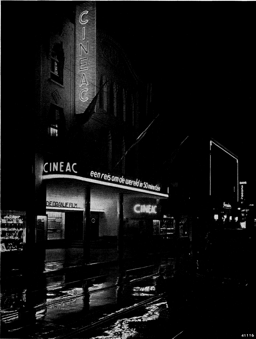
Voorbeeld van een neon lichtreclame-installatie.
