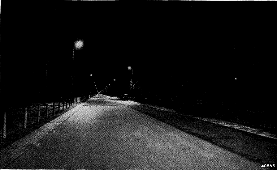
De weg tusschen Amsterdam en Haarlem, verlicht door „Philora“ natriumlampen SO 650.
