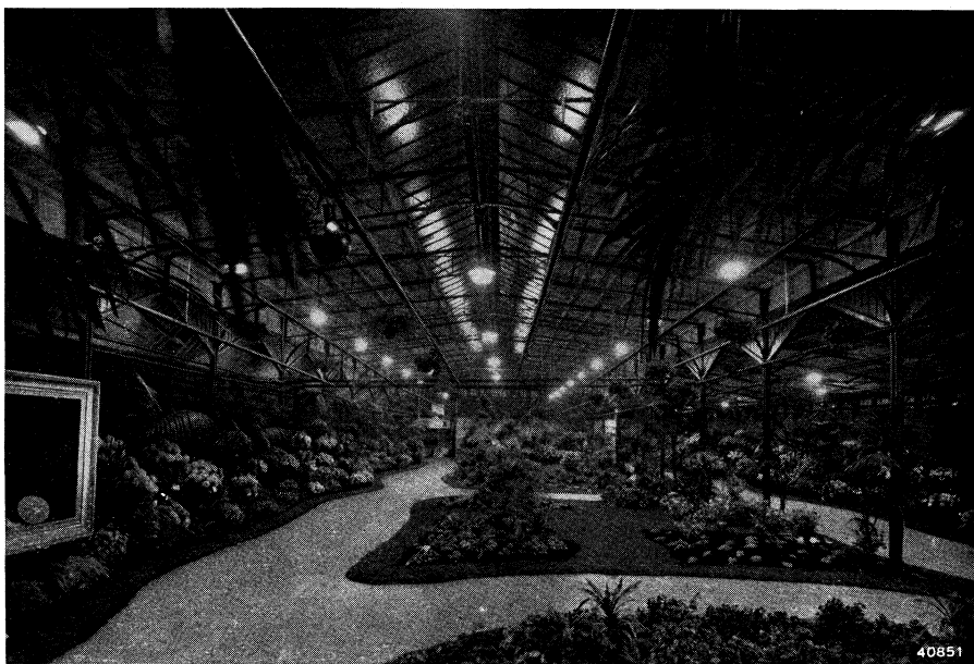
Bloementoonstelling te 's Gravenzande, verlicht door HP 300 en gloeilampen van 300 Dlm.
