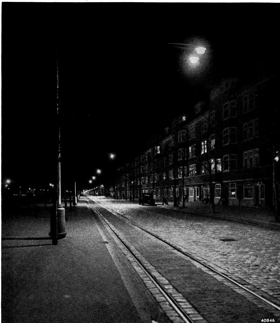
De Amstellaan te Amsterdam verlicht door „Philora“ HO 1000 lampen, hoogte 9 m, afstand 30 m.
